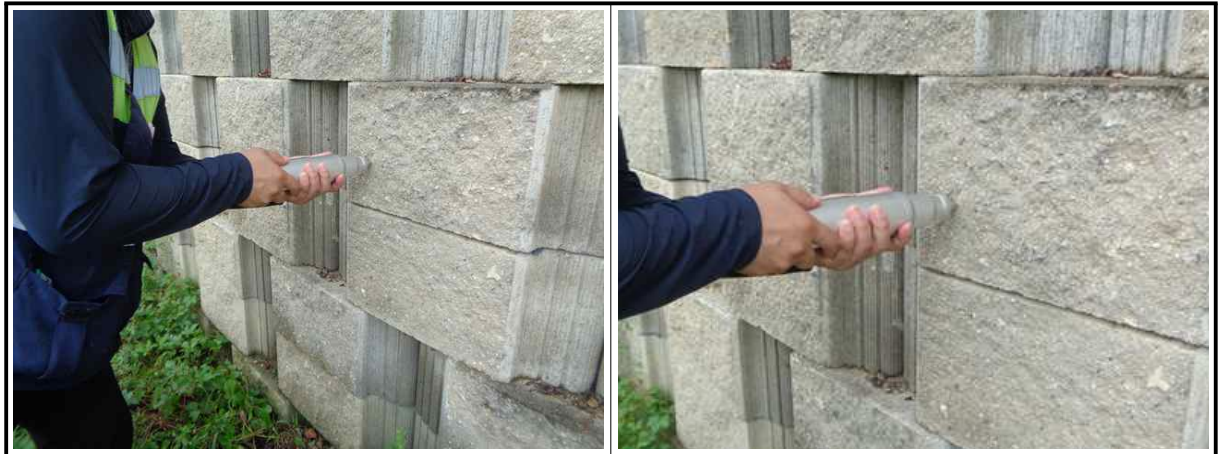
【그림 6.3.6】 슈미트해머를 이용한 반발경도시험 전경
